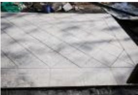
走边板精确计算，保证斜铺也全部对缝
