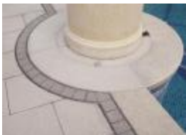
弧形排水沟径向切割示意
